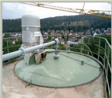
Projekt: Sanierung Silo, Ausbau Trennwände, Fertigung und Montage Silodach und Geländer in Scharzfeld, Fa. Rheinkalk HDW GmbH & Co. KG (Bild)
